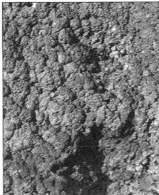
FIGURA 11 – Particolare del travertino lungo le pareti delle «fosse».
