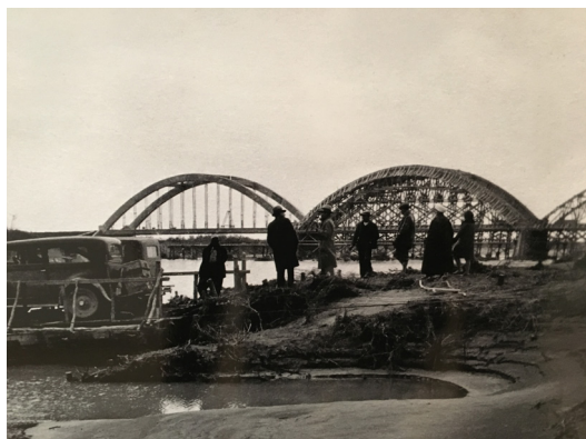
Fig. 1 Ponte di ferro nei dintorni di Valona
