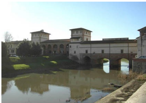
Fig.1: Ponte a Cappiano
