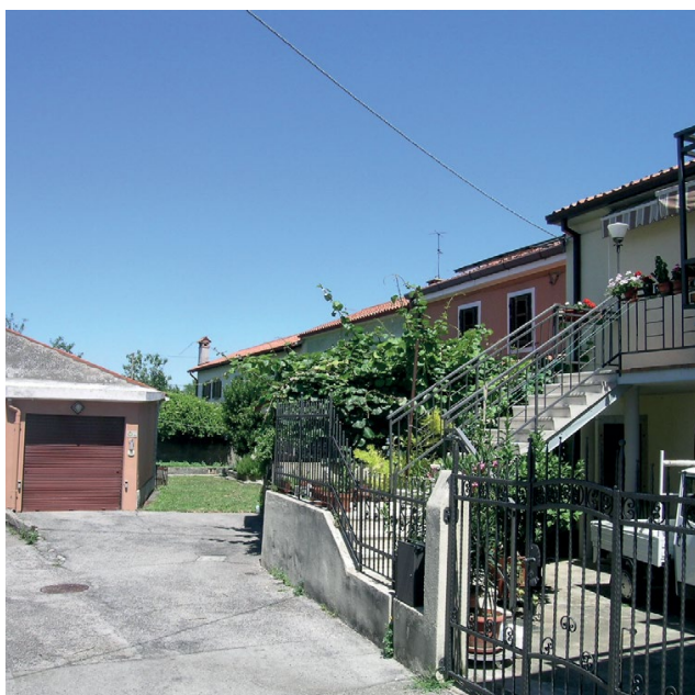
Esempi di elementi e finiture in contrasto con le tipologie ricorrenti locali.
