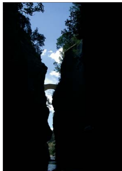
Fig. 5 – Ponte del Diavolo e tratto finale delle gole.
