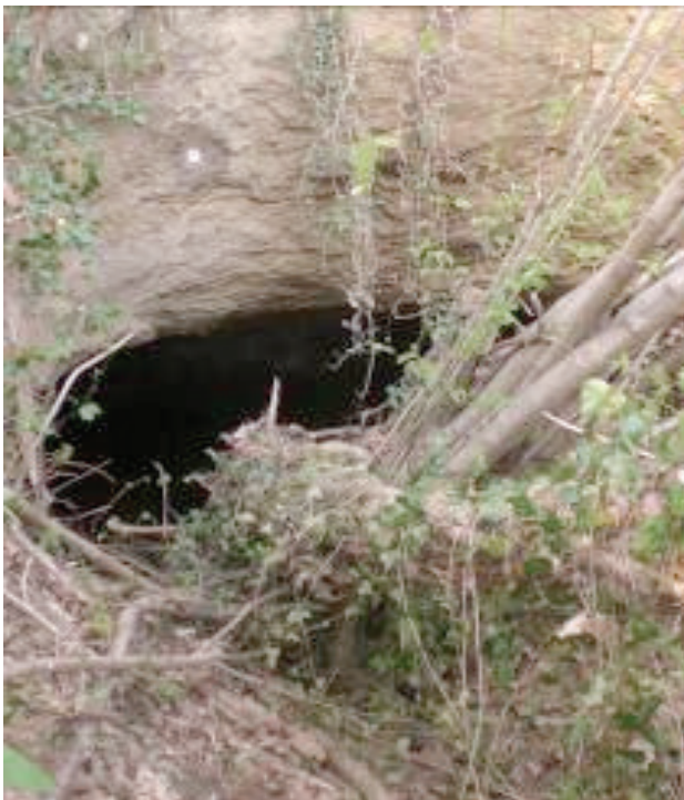
Fig. 8 L'ingresso della Grotta d'Estate parzialmente ostruito agli inizi del 2011 dalla caduta di alcuni individui arborei
