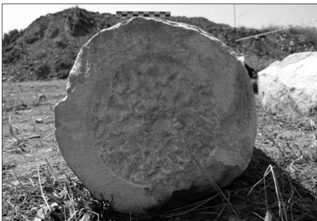
Fig 12. Faccia di posa di colonna dorica in pietra calcarea di Aurisina. Si riconoscono l' anathyrosis e il punto centrale.
