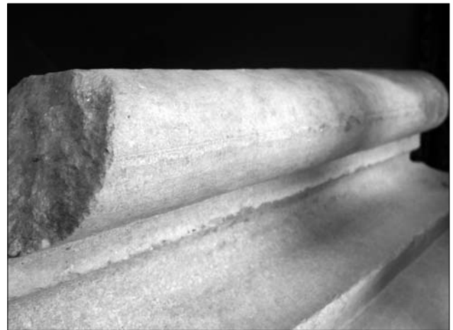
Fig 10. Modanatura superiore della base attica di lesena. Si osserva la traccia rettilinea nel punto di massima espansione del toro superiore.
