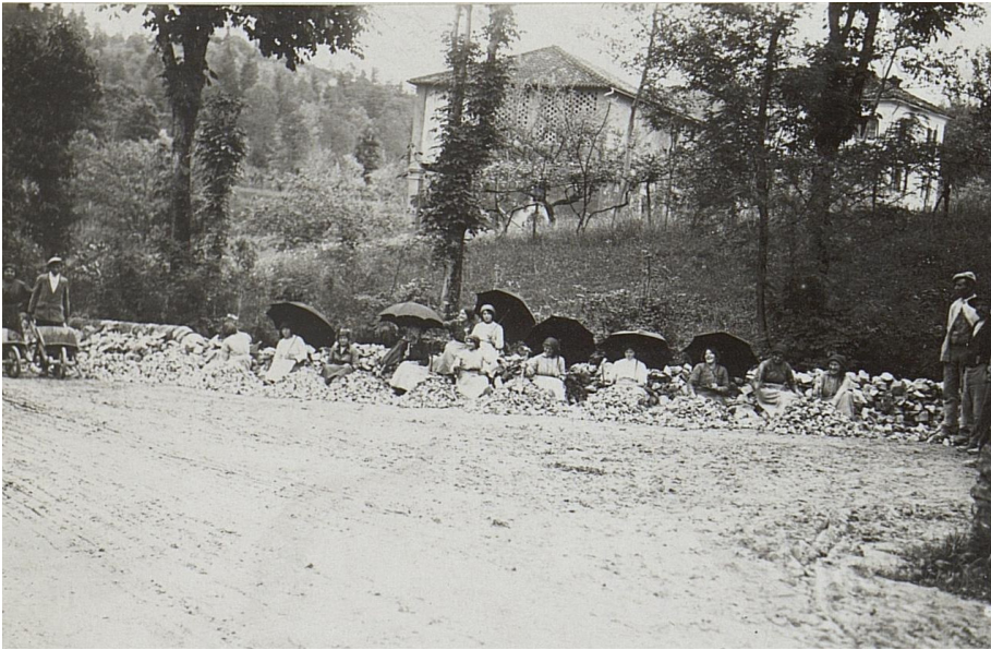
Figura 4 – Dusoi 1918. Lavori di manutenzione stradale sulla Limana-Belluno. Fonte – Kriegspressequartier Alben, WR1/ALB092/27214
