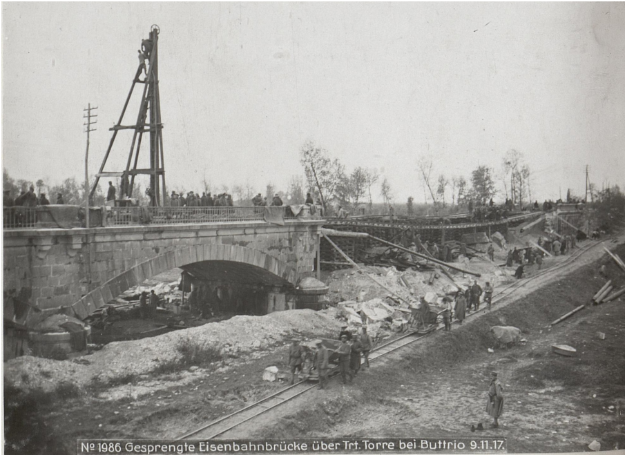
N° 1986 Gesprengte Eisenbahnbrücke über Trf. Torre bei Buttrio 9.11.17.
