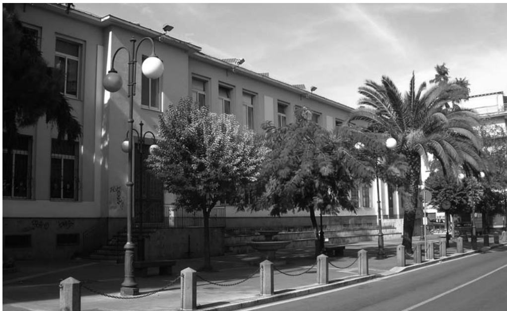
Riqualificazione degli spazi aperti di pertinenza dell'edificio scolastico I Circolo Didattico De Curtis, Plesso Corso Umberto a Casalnuovo di Napoli.
