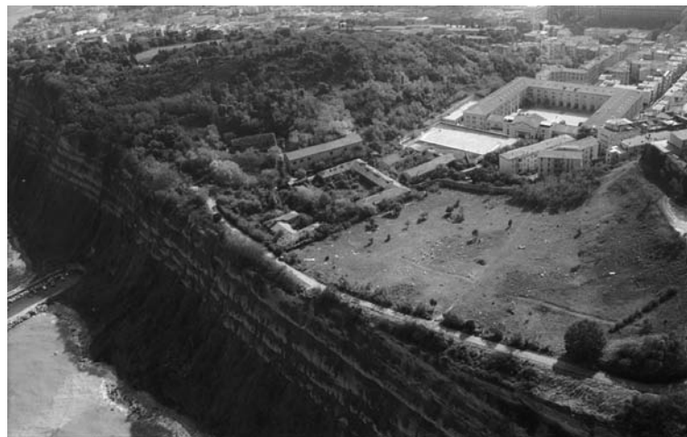
Foto aerea dell'area della falesia
