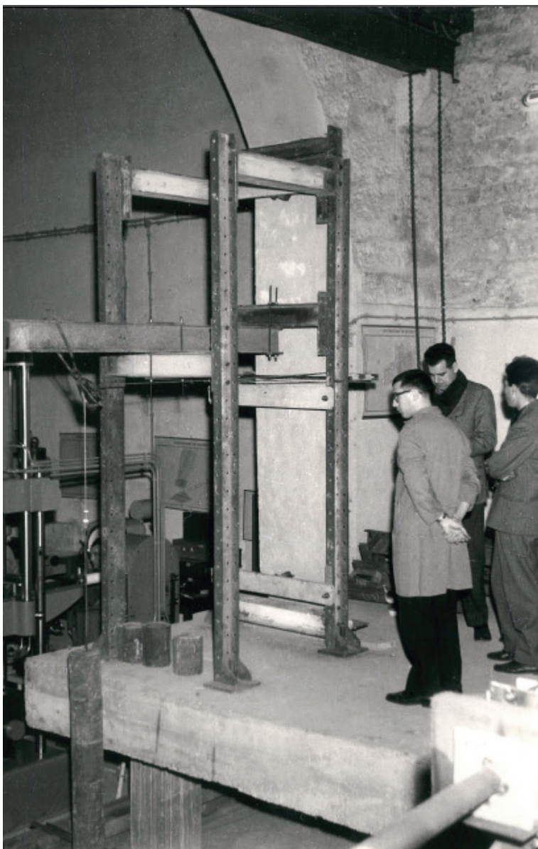
Prova su un modello di pannello prefabbricato: assistono il prof. Costa, l'ing. Sforzina ed il sottoscritto (archivio privato)
