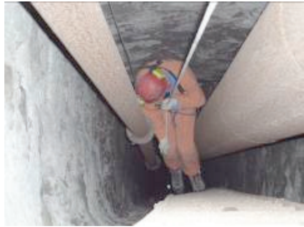
Fig. 3 La discesa del pozzo nei suoi primi metri. Due tubazioni ed una scala fatiscente rallentano i lavori
