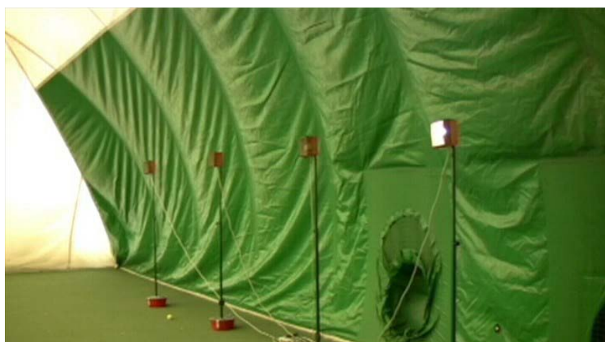
Figura 5.2 - Sistema di luci alle spalle del battitore, che indicava al soggetto dove indirizzare la palla.
