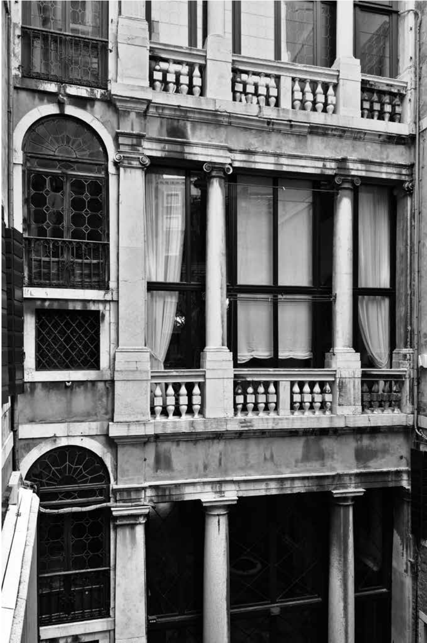
6 - Venezia, Palazzo Contarini degli Scrigni, scorcio dell'affaccio della "casa nova" sulla corte
