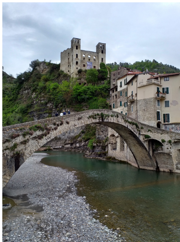
FIGURA 8 – Dolceacqua, il ponte sul Nervia e il Castello Doria
