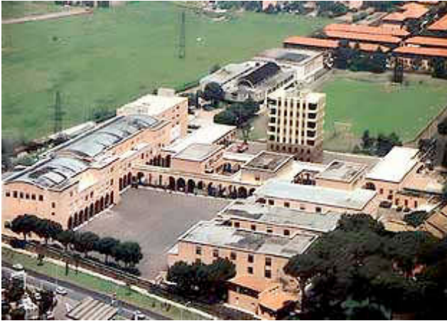
Scuola Formazione di Base Capannelle
