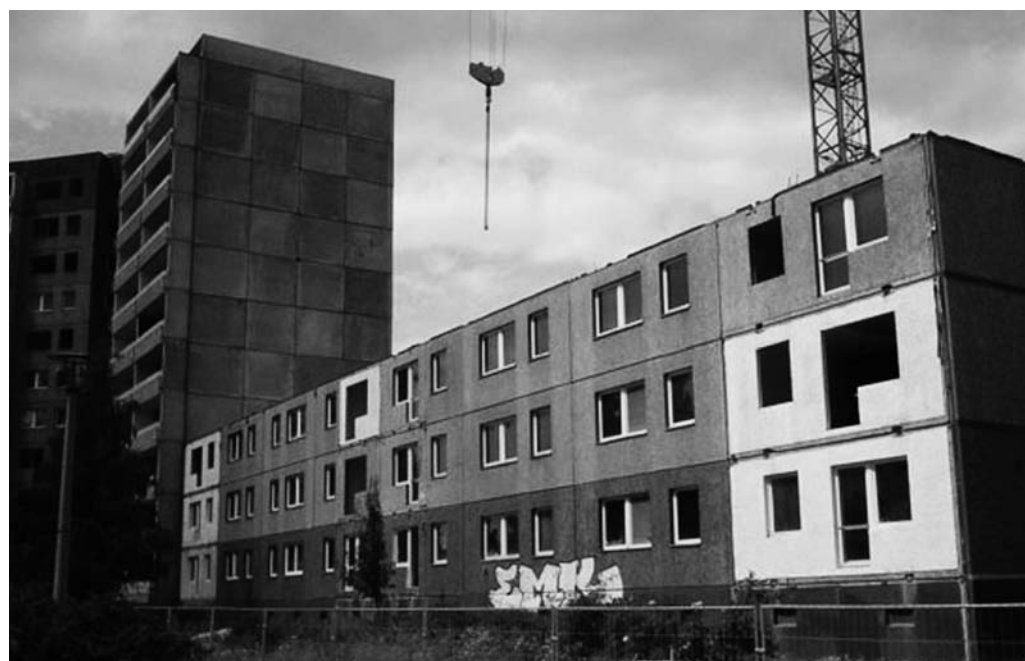
Fig 2: Ahrensfelder Terrassen, i cantieri della decostruzione: gli edifici vengono "smontati" pezzo per pezzo, grazie agli elementi prefabbricati da cui sono costituiti (Da: www.marzahn-nordwest-quartier.de ).
