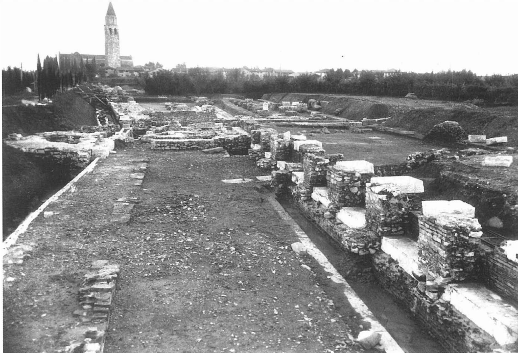
Fig. 7. Fronte dei magazzini. Neg MAN 1988: “lo scavo del porto canale visto da N a Sud dopo l’asporto della terra fra il primo e il secondo muro dei magazzini, sett. 1933”.
