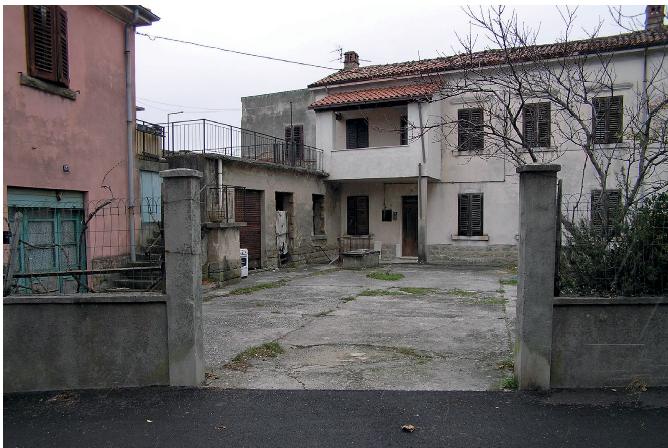
Edifici in stato di abbandono, con superfetazioni (poggiolo visibile in fondo) e interventi non coerenti con l'esistente sia in pianta sia in alzato.
