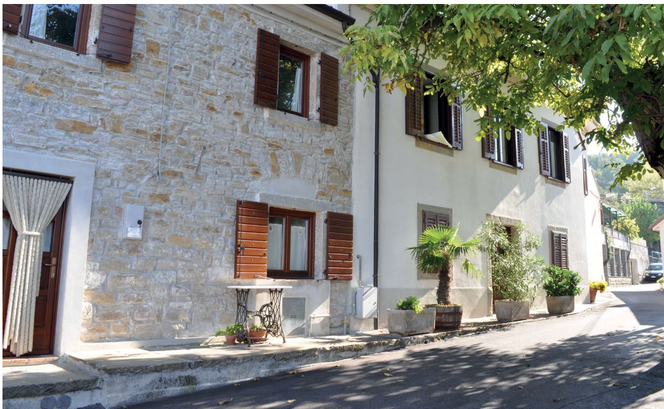
La muratura in arenaria è stata lasciata in vista sulle facciate degli edifici solo in fabbricati accessori. Pochissimi i casi, come quello della foto, in cui si nota che la muratura è stata ripristinata e rimessa alla luce, peraltro in questo caso con un risultato ben riuscito.
