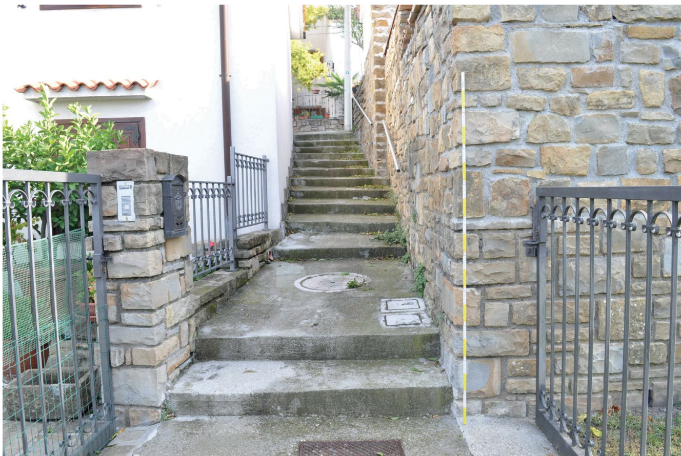
Scala che connette due vie di accesso al borgo di Santa Barbara. I muri di recinzione, di recente fattura, utilizzano il materiale tradizionale, la pietra arenaria estratta dalle vicine cave.
