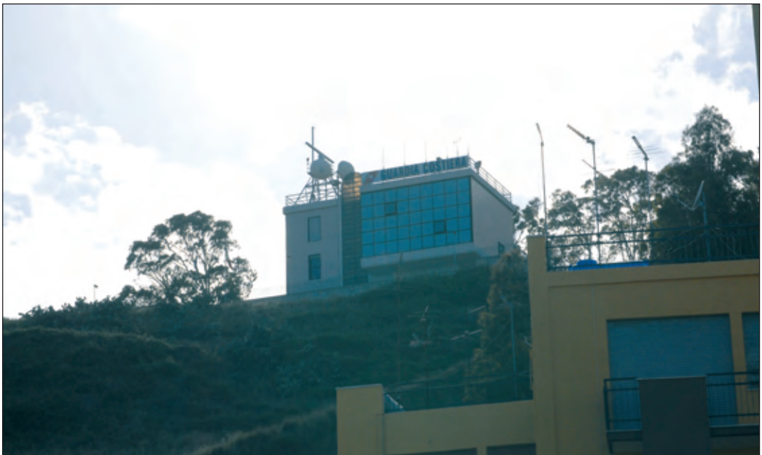
Fig. 3 - Il sistema radar (Vessel Traffic Service) VTSL, sulla collina di Forte Ogliastrì
