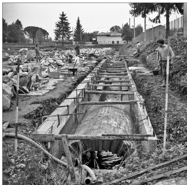
Fig. 4. Aquileia, Foro romano, cunicolo per il deflusso delle acque.
