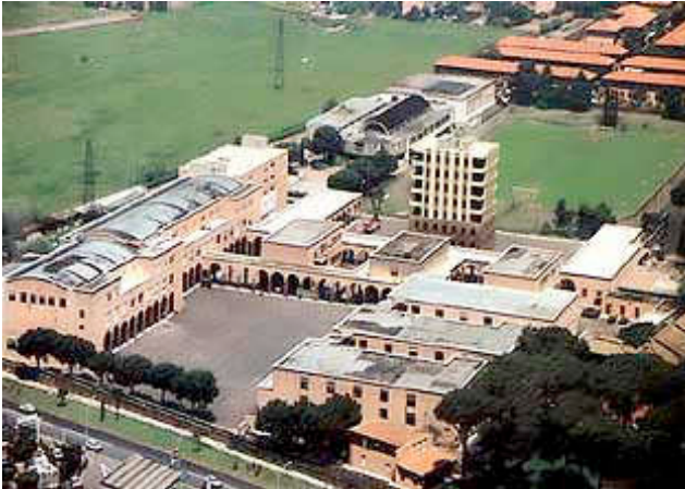
Scuola Formazione di Base Capannelle
