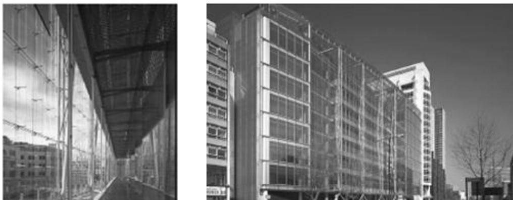
Fig.72. Esempi di facciate continue a lastre indipendenti.
