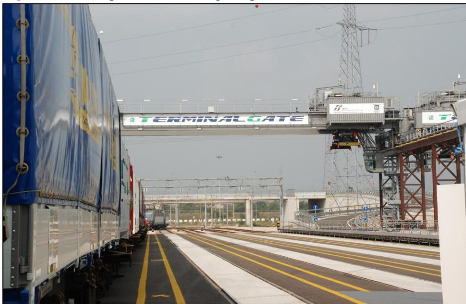
Figura 3 Vista e particolare delle gru a portale QETG
