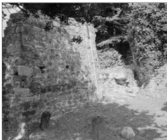
Fig. 8. La struttura muraria (terrazzamento?) sottostante l'abside settentrionale della basilica civile.
