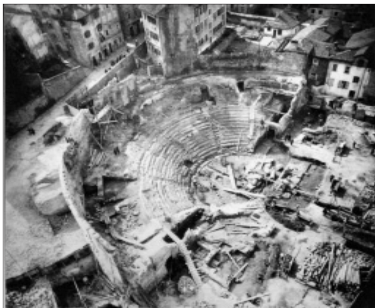
Fig. 15. I lavori di isolamento del Teatro romano, 1937 (ACS, MPI, AA.BB., D.II, b.20).
